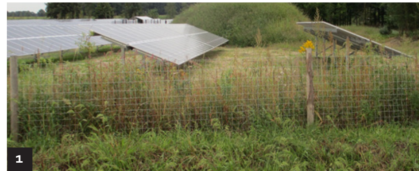
Onopvallend hekwerk met houten palen en schapengaas.
