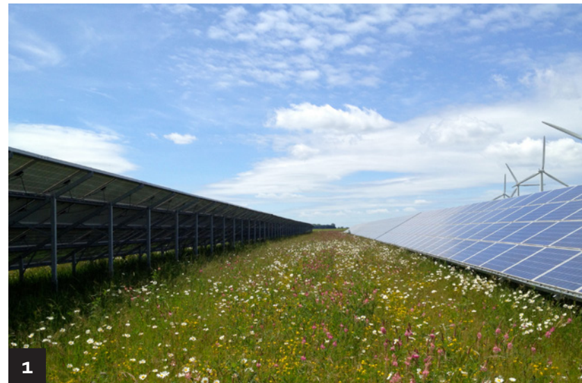
Kruidenrijk grasland onder zonnepanelen.
