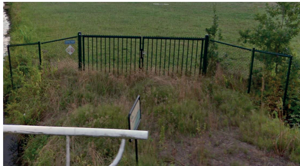
Hekwerk van het waterschap aan overzijde van de Koedijkerweg.
