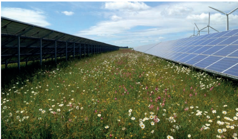
Referentiebeeld bloemrijk grasland onder zonnepanelen.
